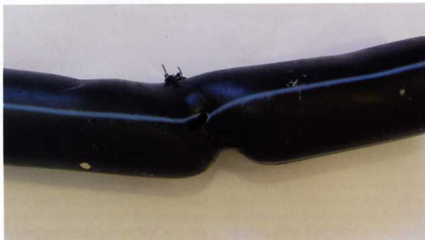
Et tau har gnagd seg gjennom og inn i en vannledning. Det forårsaket en lekkasje hvor flere hytter mistet vannet. Foto: Aslaug Koksvik
